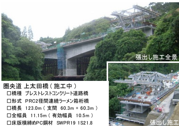
図-10 圏央道 上太田橋(施工中)
