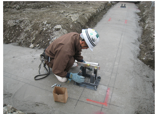
ベースアングル設置
