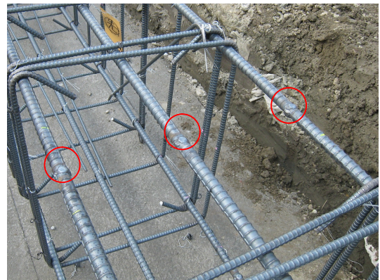
鉄筋継手位置
