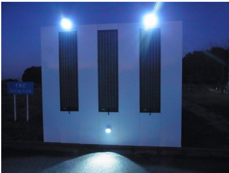
図8 夜間のLED照明の様子（芳賀）
