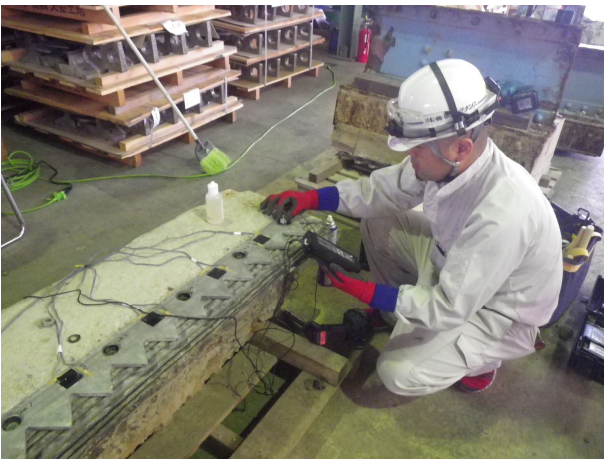
写真 3 超音波軸力計によるボルト長計測状況
