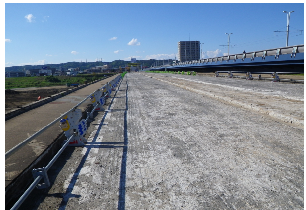
写真 1 床版撤去前の旧富山大橋
