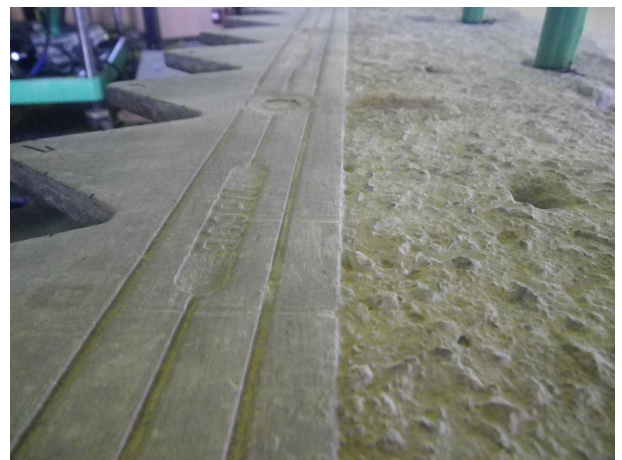
写真 5 伸縮装置表面の状態
