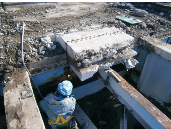
写真2 伸縮装置採取状況
