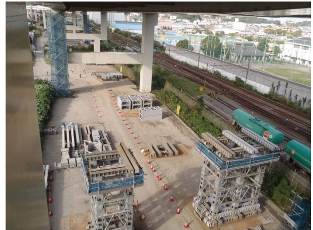
写真2 ベント組立状況（P33から撮影）
