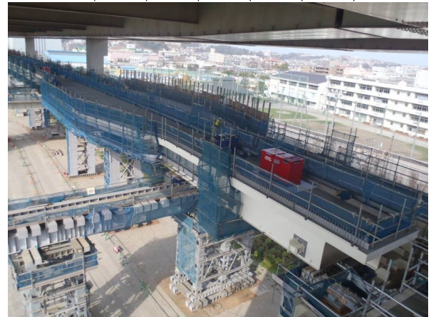
写真3 G1桁横取り前（P33から撮影）
