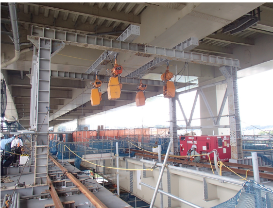
写真6 吊り上げ機
