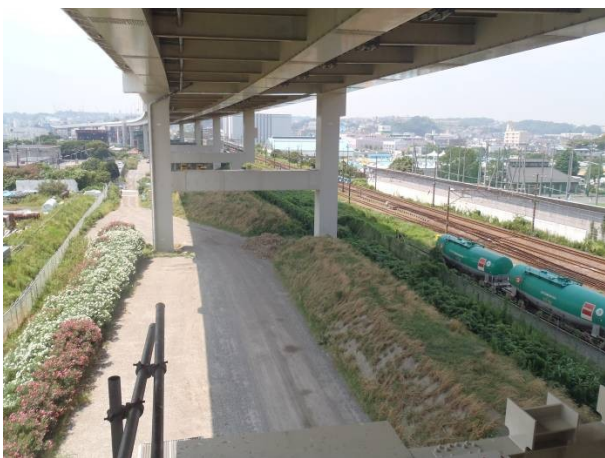
写真1 工事着手前（P33から撮影）
