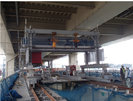
写真7 中鋼床版、横桁の架設
