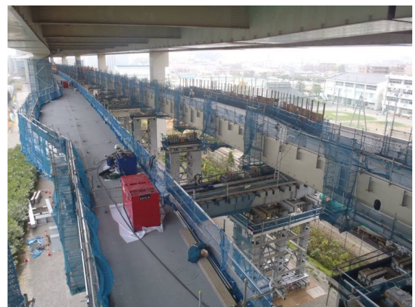
写真4 G1桁横取り後（P33から撮影）
