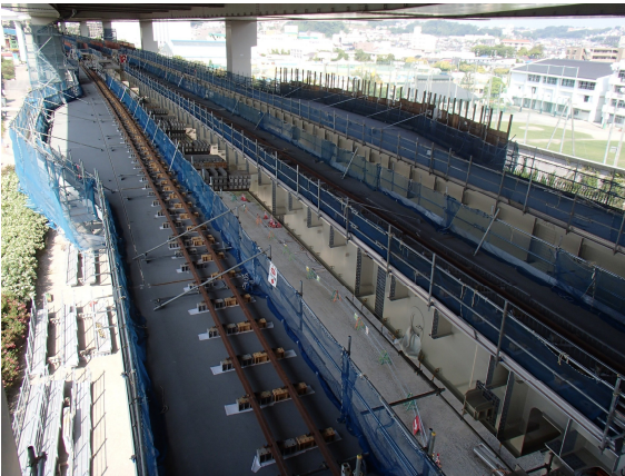
写真5 横取り架設完了後（中床版架設前）
