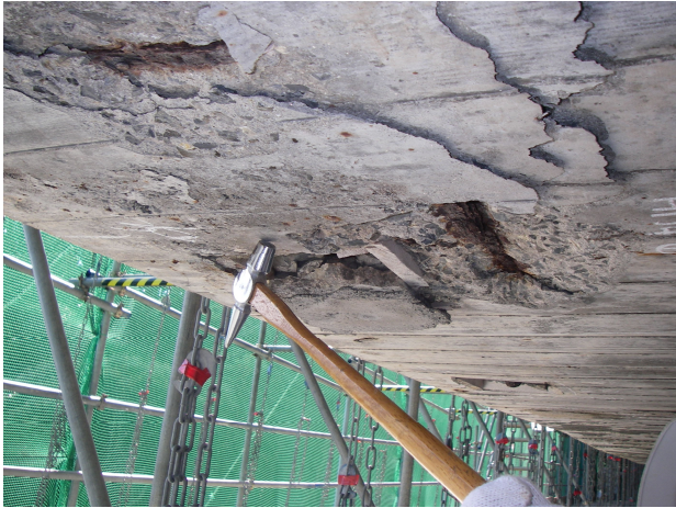
写真2 外面調査劣化・損傷状態
