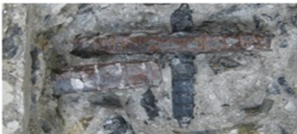
写真4 既設鉄筋確認
