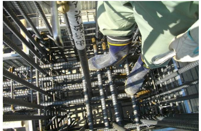
写真14 アンカー干渉確認状況
