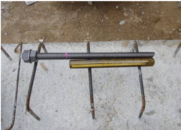
写真5 ケミカルボルト(上)・カプセル(下)
