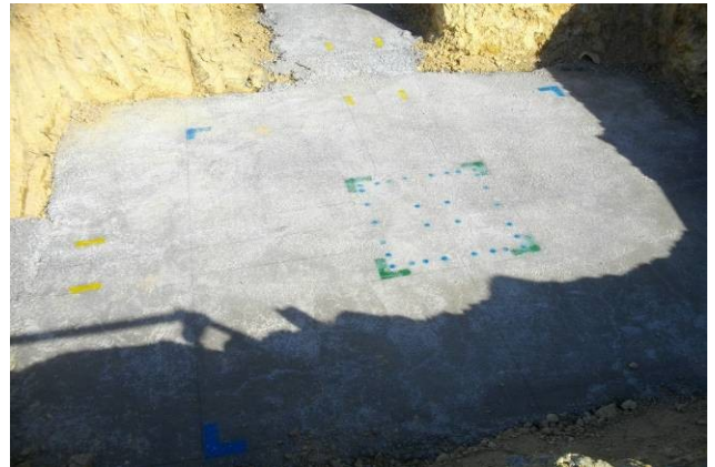
写真13 捨てコンクリート上のマーキング
