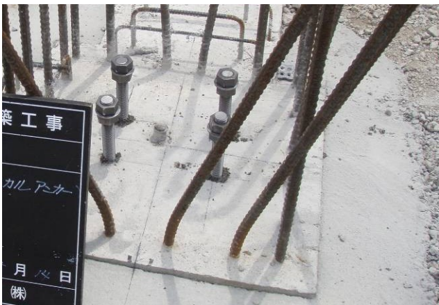
写真7 あと施工アンカーの施工後
