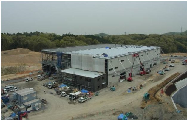
写真 16 太陽光パネル設置状況全景
