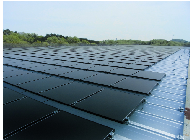
写真 19 太陽光パネル設置状況
