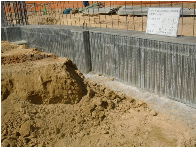
写真11 コンクリート打設完了
