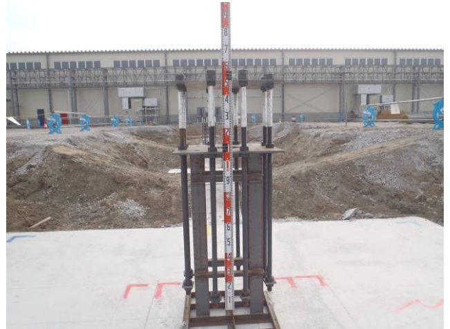
写真8 アンカーフレーム
