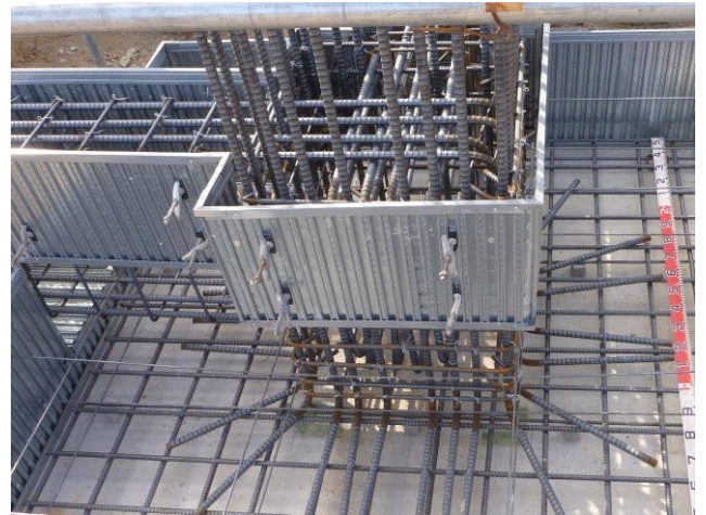
写真9 配筋後(アンカーフレーム無し)
