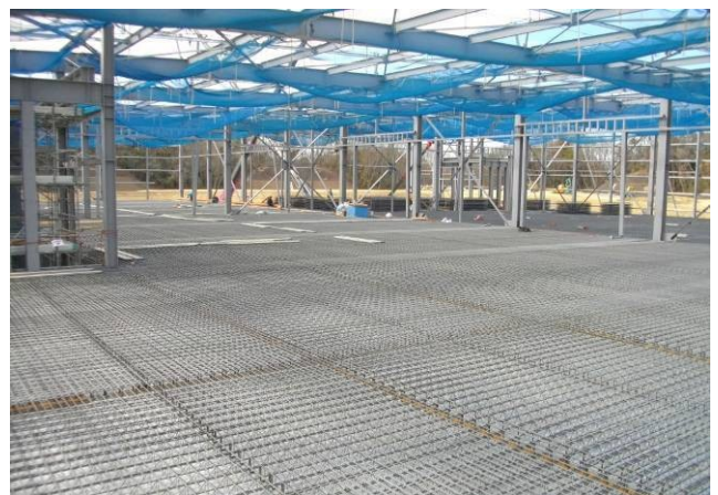
写真4 鉄筋トラス付捨型枠施工後
