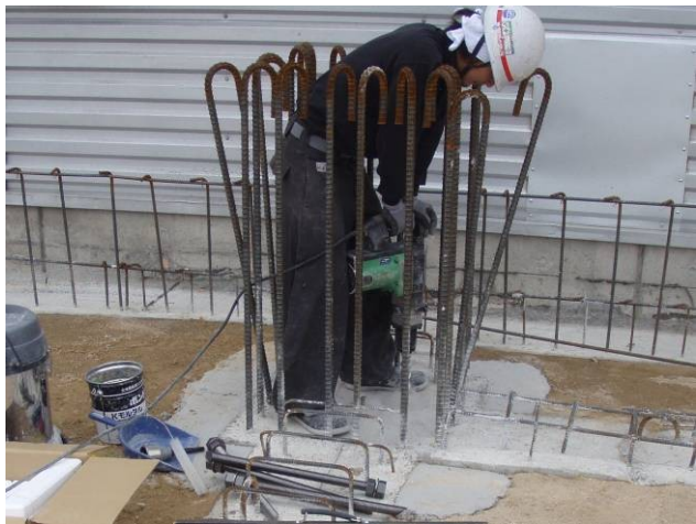
写真6 削孔状況
