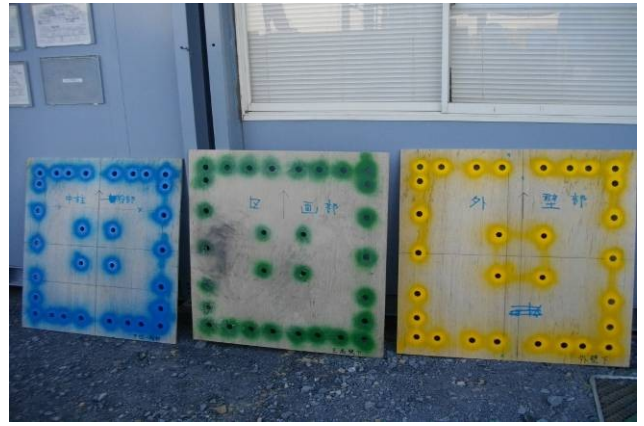
写真12 ベニヤ製テンプレート
