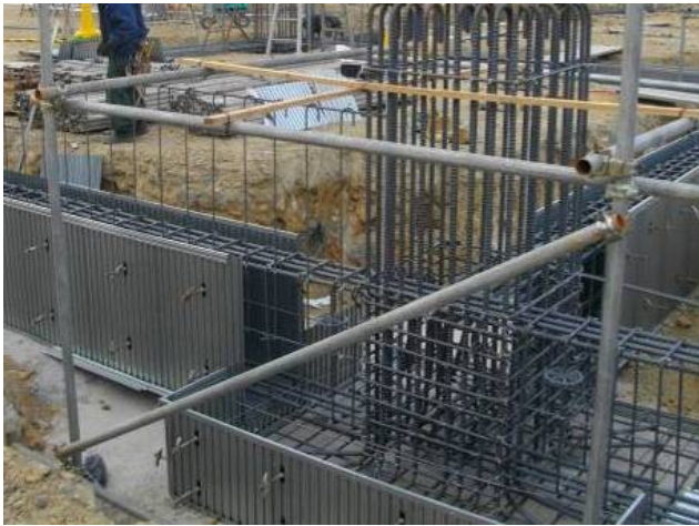
写真10 超薄型鋼製打ち込み型枠の施工状況
