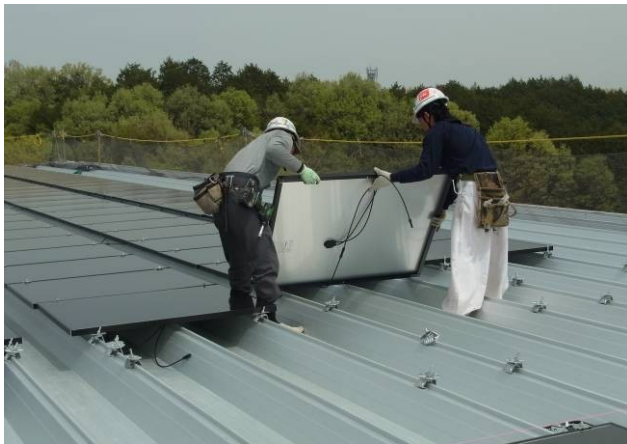
写真 17 太陽光パネル設置状況
