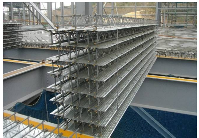
写真3 鉄筋トラス付捨型枠
