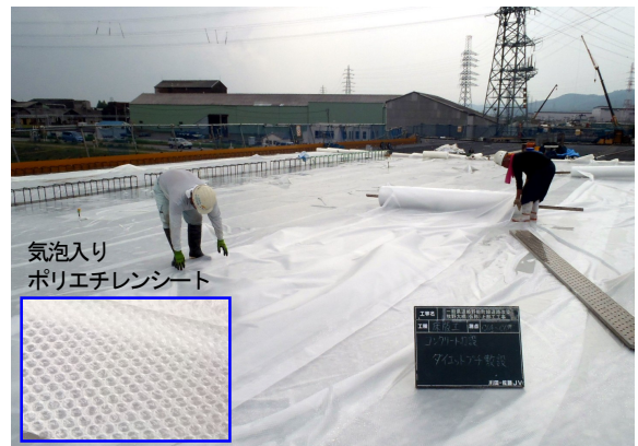
気泡入りポリエチレンシート設置状況
