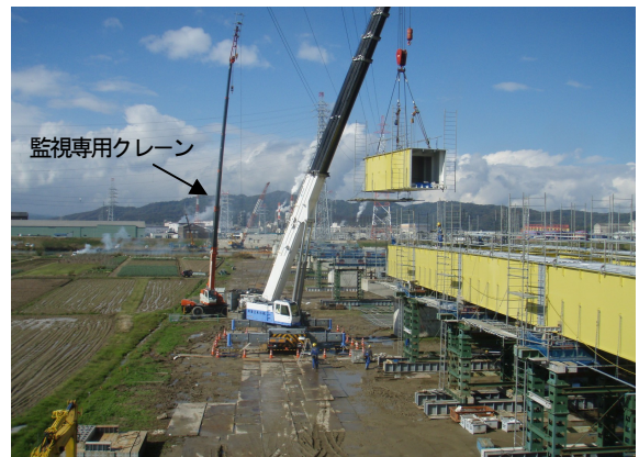
架設状況写真
