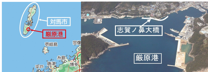
施工位置図，厳原港橋梁位置写真
