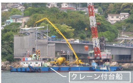
生コン打設写真
