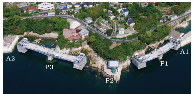
張出施工時写真
