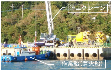
生コン積み替え写真
