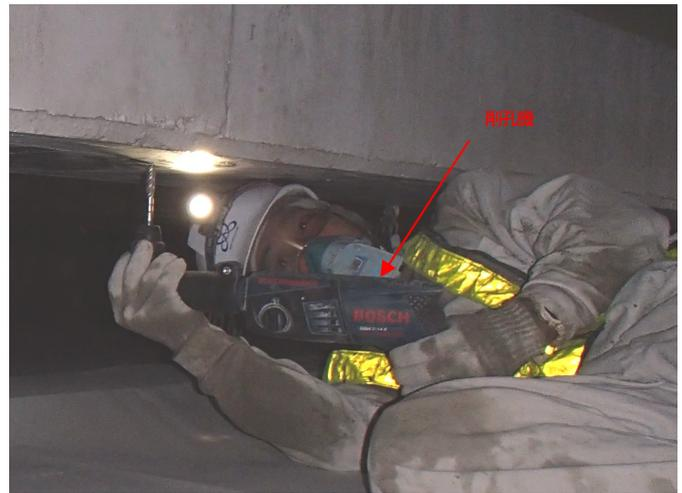
機械高が低い削孔機
