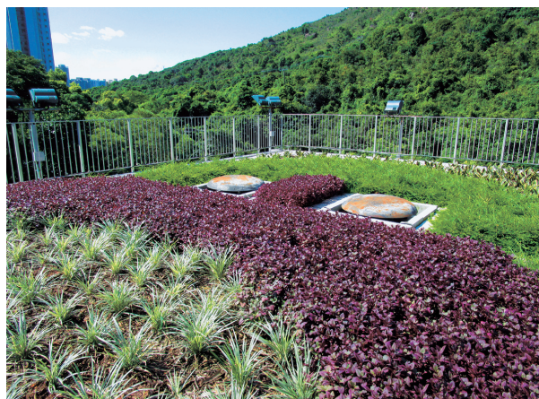
Tai Shui Hang Lowland Raw Water Pumping Station（香港 大水坑：2014年）
