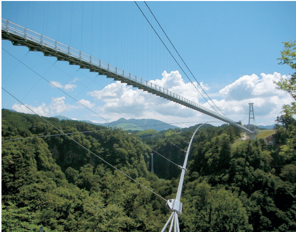
九重“夢”大吊橋（大分県九重町：2006年）
