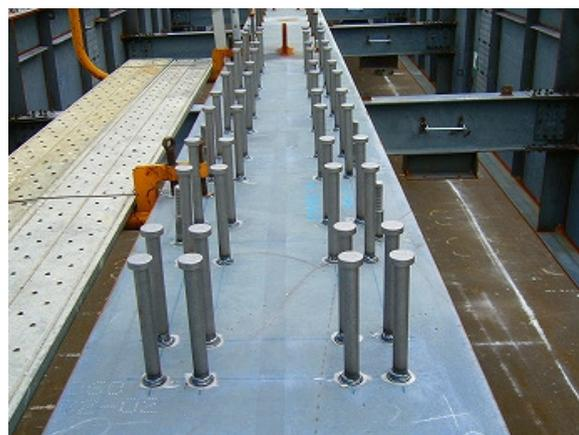
写真 6 主桁上フランジのスタッド配置状況
