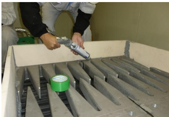
写真 15 型枠設置状況
