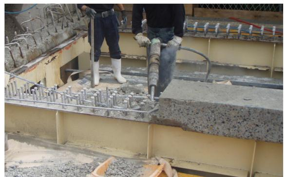
写真14 主桁上床版の破碎状況
