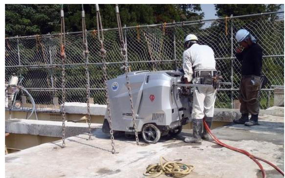
写真13 桁間部の切断状況
