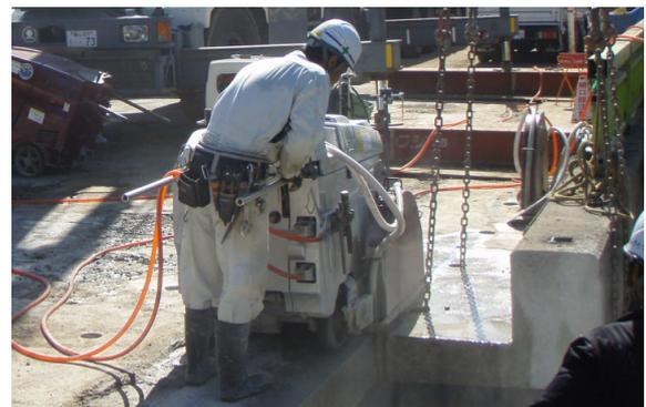
写真12-b 床版張出部の切断状況(コンクリートカッター)
