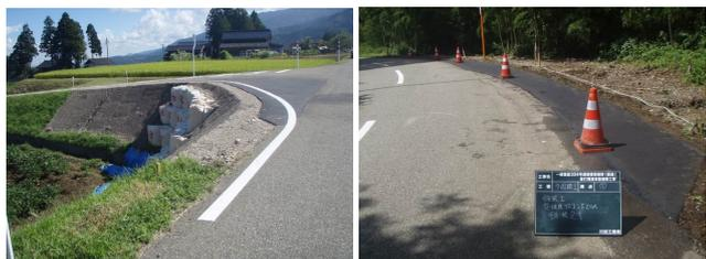
写真 4 隅切り部造成状況 写真 5 待避所設置状況
