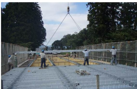
写真 18 合成床版パネル架設状況
