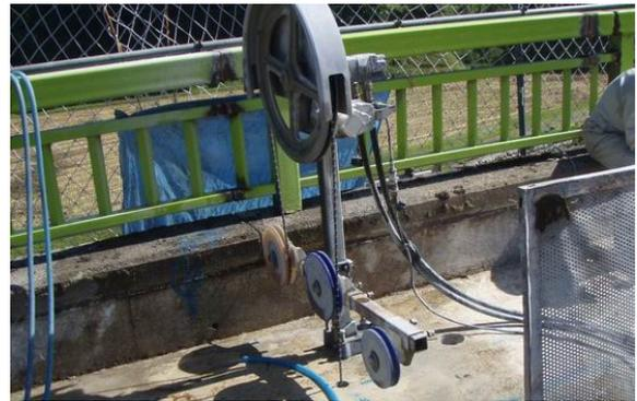
写真12-a 床版張出部の切断状況(ワイヤーソー)
