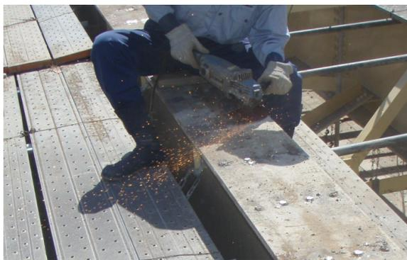
写真 15-b 既設フランジ グラインダー仕上げ状況
