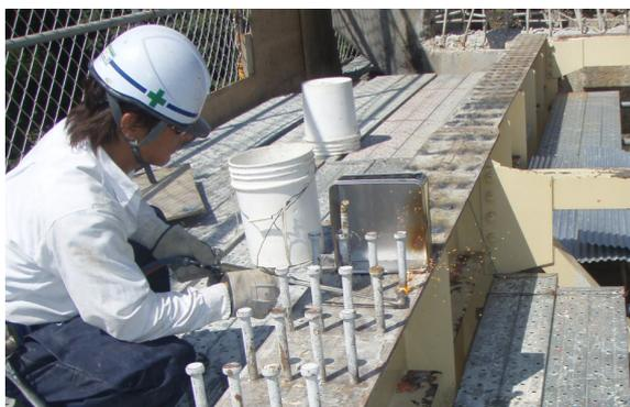
写真 15-a 既設スタッドジベル切断状況
