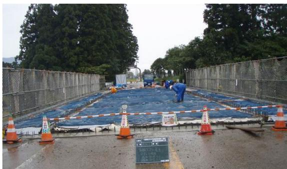
写真20 床版コンクリートの養生状況
