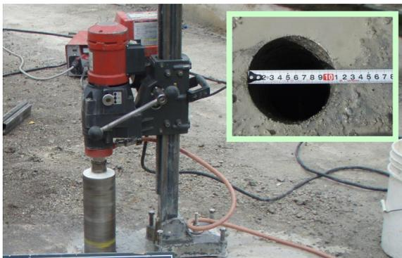
写真11-a 床版吊込用孔φ100 削孔状況
