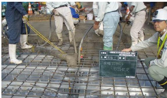
写真19 床版コンクリートの打設状況
