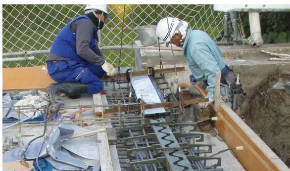
写真21 伸縮装置設置状況
