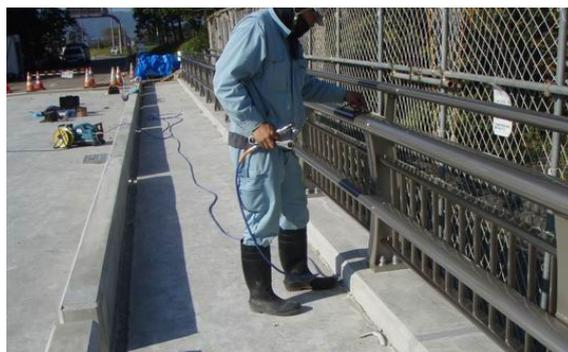
写真22 車両用防護柵設置状況
