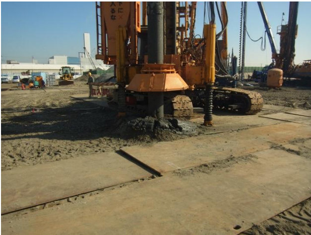
写真1 静的締め砂杭工法の工事状況
