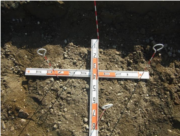
写真2 砂杭の施工後の状況
