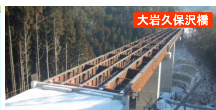
大岩久保沢橋
