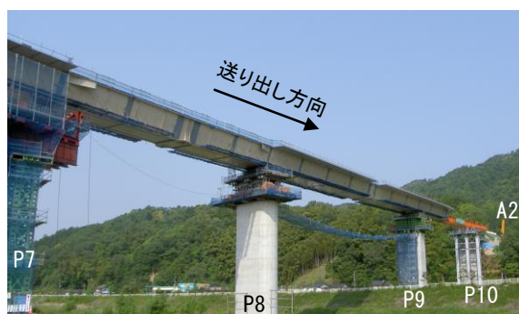
写真1 送出し架設状況 (A2到達時)
