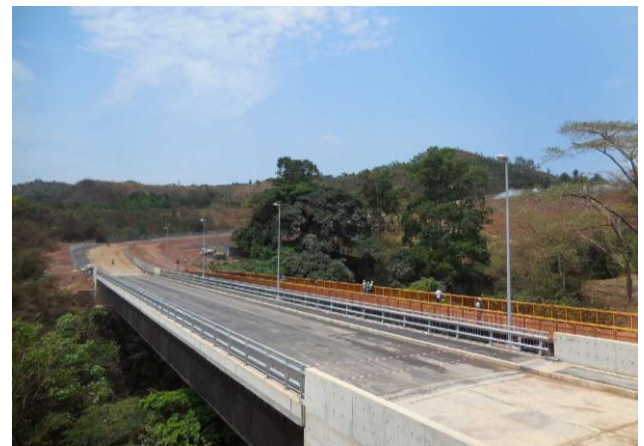
施工完了状況
