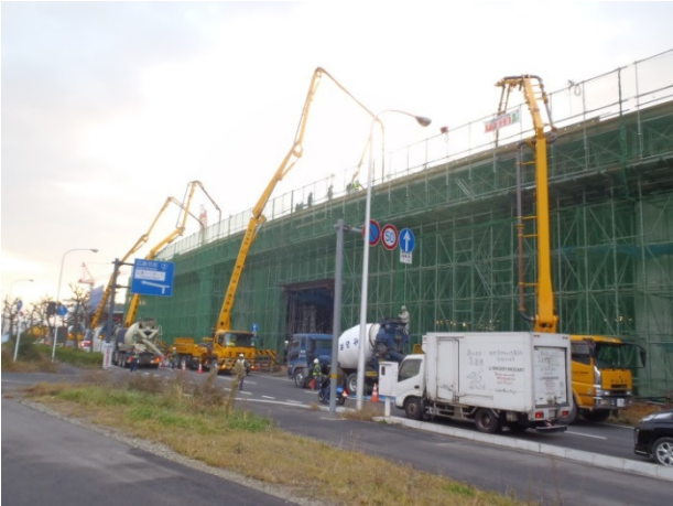
コンクリート打設状況
