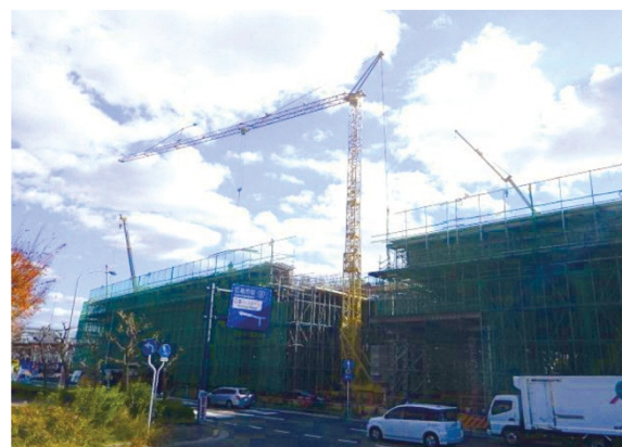
タワークレーンによる揚重作業
