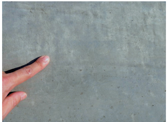
写真 5 打込み 26 日後のコンクリート表面
