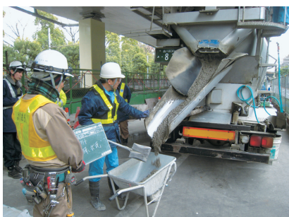
写真6 早強性軽量コンクリートの受入れ(左)と打込み状況(右)
