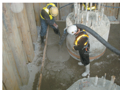
写真6 早強性軽量コンクリートの受入れ(左)と打込み状況(右)
