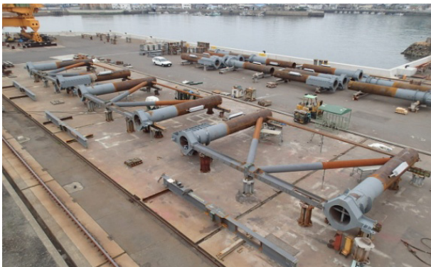
写真 4 面組立製作状況
