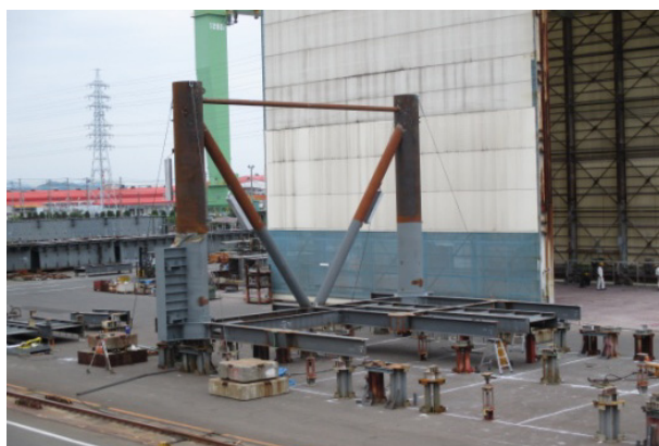
写真 6 立体大組立状況
