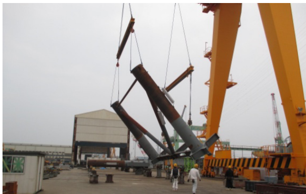
写真 5 面組部材の立越し状況
