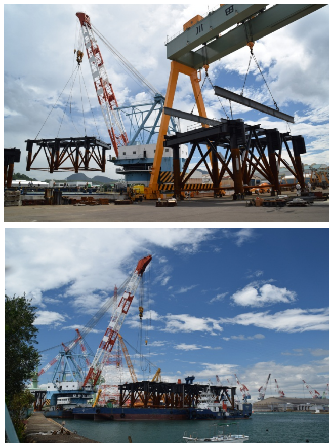
写真9,10 浜出作業状況
