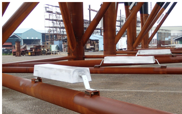
写真1 アルミニウム合金陽極の設置状況
