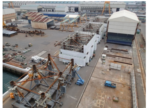
写真 7 溶接および塗装用の風防設備状況
