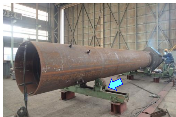
写真 3 ターニングローラーを用いたレグ製作
