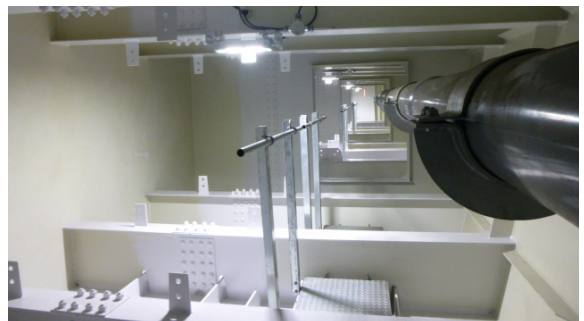
箱桁内の維持管理設備(歩廊と照明設備)
