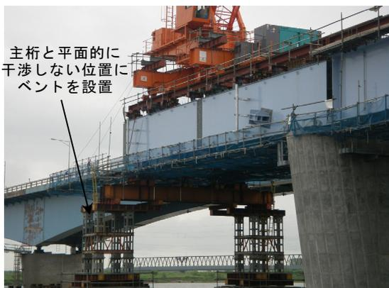
写真3 ベントと主桁の干渉回避
