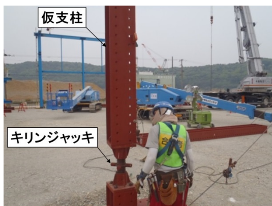
改善後の仮支柱実施状況
