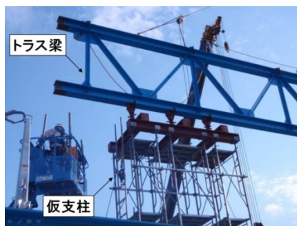
仮支柱実施状況
