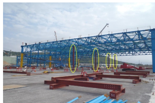
仮支柱架設状況
