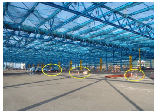
仮支柱解体完了状況
