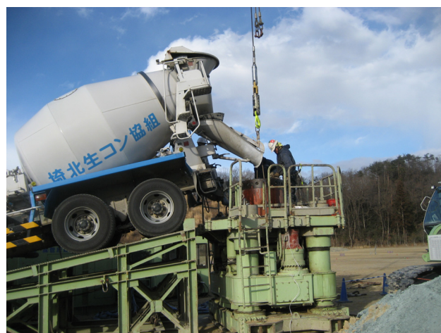
写真4 コンクリートの打設
