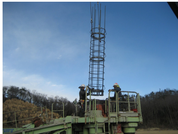
写真3 鉄筋かごの建て込み
