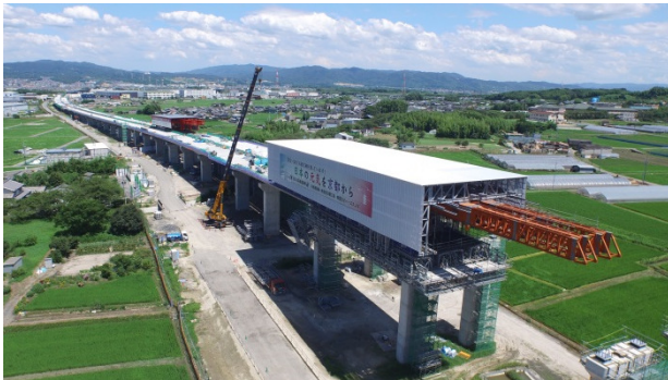
写真1 移動支保工全景
