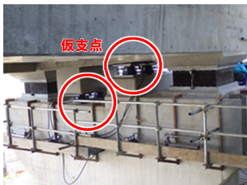
写真 2 仮支点ジャッキ配置状況
