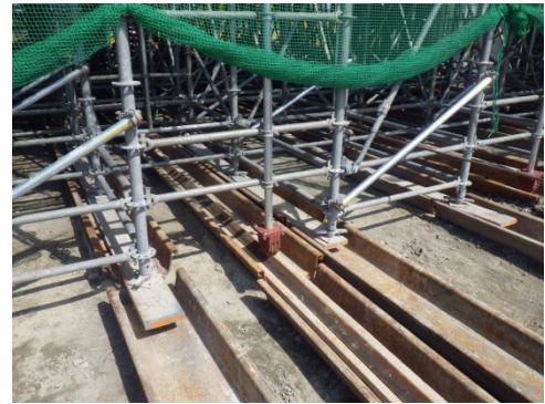
写真 10 横取り時ローラー設置
