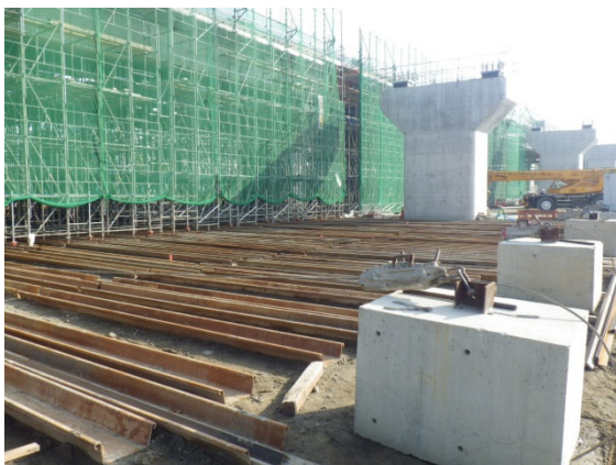
写真 9 支保工横取り前全景
