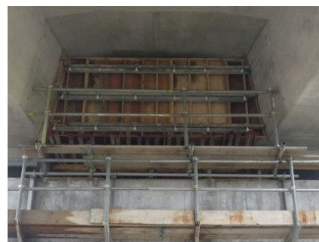
写真 4 横桁内部支保工図
