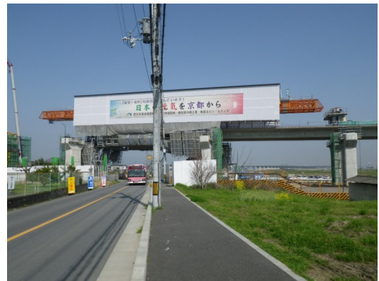
写真 3 府道上施工時全景
