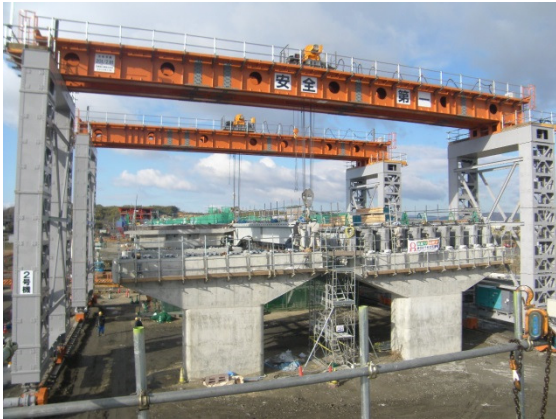
写真7 主桁架設状況
