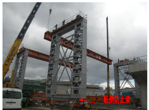
写真 6 門型クレーン組立状況
