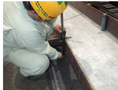
写真1 座屈拘束材の寸法検査状況
