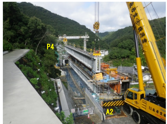
写真 1 相吊り架設状況
