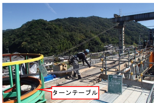
写真4 PCケーブル挿入状況
