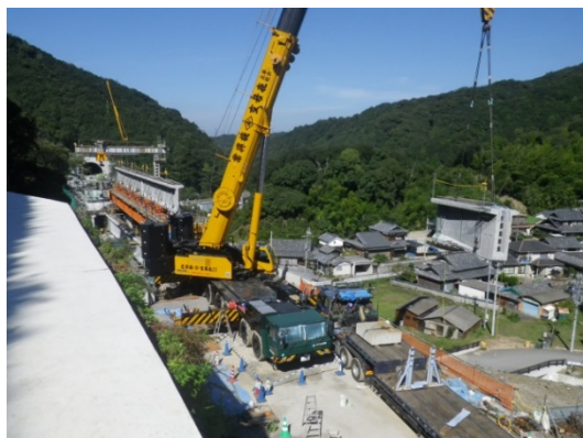
写真2 セグメント取り降ろし状況
