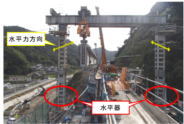
写真8 水平器取り付け箇所
