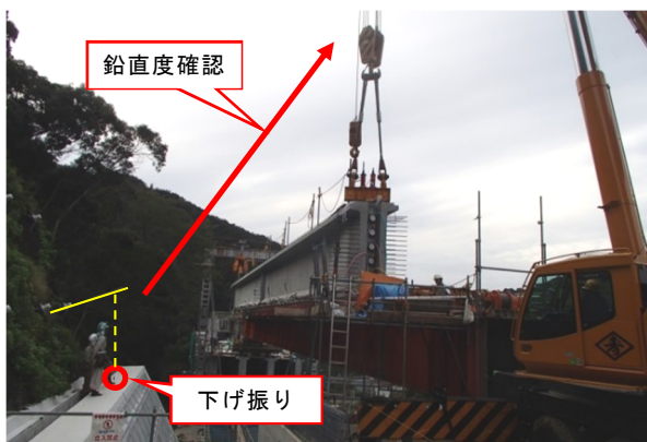
写真7 下げ振りによる鉛直度確認状況
