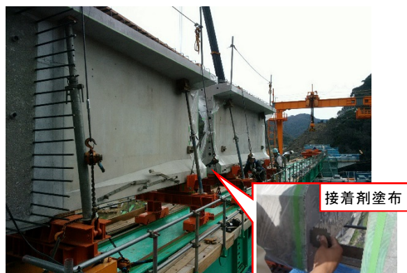
写真3 セグメント接合状況
