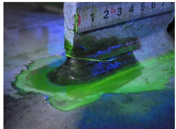
写真 1 A2 タイプのき裂
