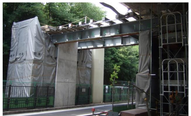
写真4 支保工桁設置完了写真
