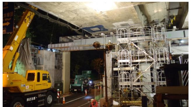
写真3 支保工桁の夜間送出し状況写真
