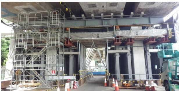
写真2 作業帯内での支保工桁地組立完了写真
