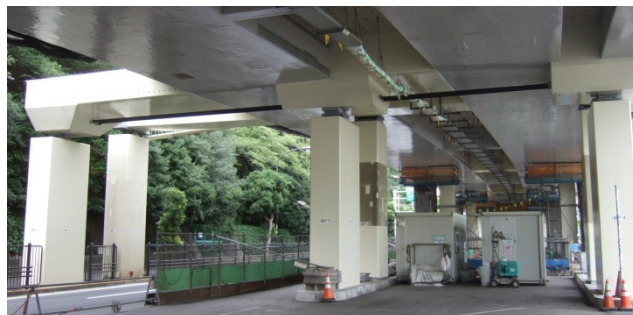
写真5 新設橋脚部完了写真
