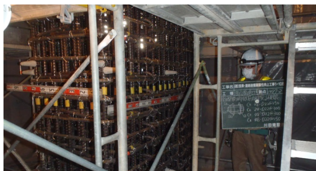
写真4 柱鉄筋組立完了状況写真
