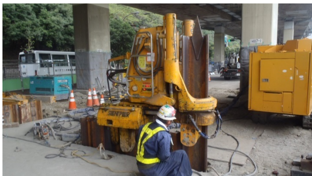
写真2 サイレントパイラーの施工状況写真
