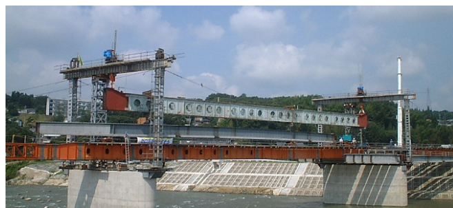
写真1 吊下げ式による架設桁架設の例
