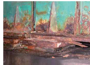
(a) 支点部の腐食
