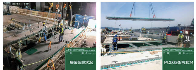
(a) 支点横梁の架設 (b) 支点横梁上の PCaPC 床版架設
