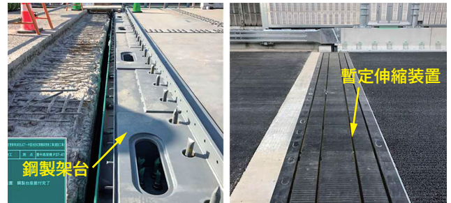
写真10 暫定伸縮装置設置状況 (左：鋼製台座据付、右：本線伸縮装置設置)
