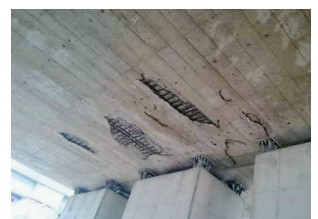
(f) RC 中空床版の浮き・剥離
