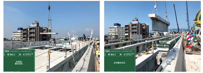
(a) 既設床版撤去 (b) 既設桁撤去
