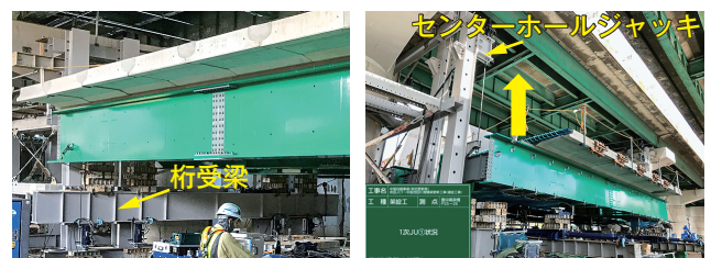
(a) 桁受梁上に新設桁設置
