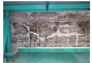
(b) 床版下面のひび割れ
