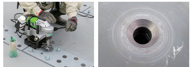
写真7 現場皿孔加工と連結板の皿孔加工後の状況
