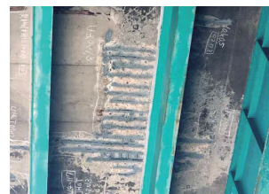
(c) 床版下面の浮き・剥離
