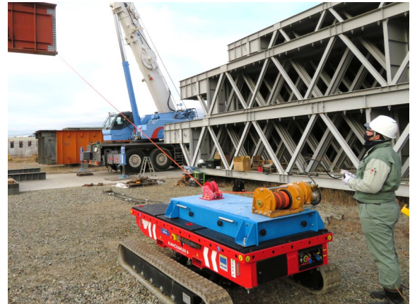
(写真2) 操作はオペレータ1人
