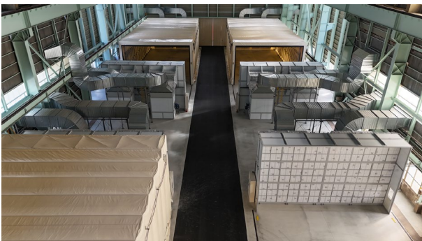
ヤード内に4つのブースを設置
