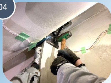
支圧ボルト設置
