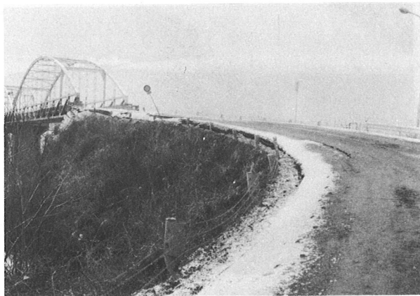
写真-1 左岸側取付道路
