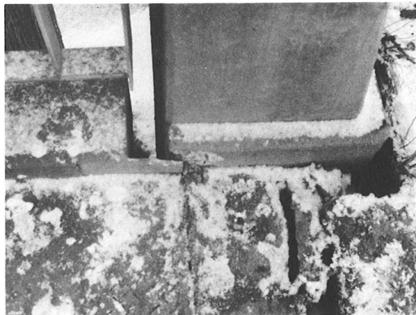
写真-3 左岸側橋台と親柱付近
