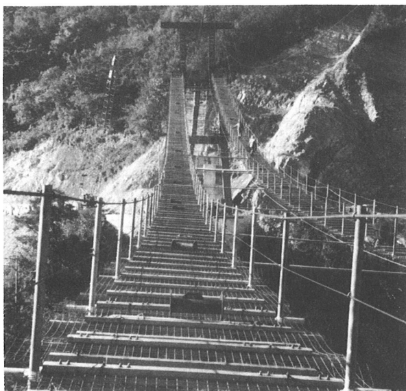
写真-10 床組の完了
