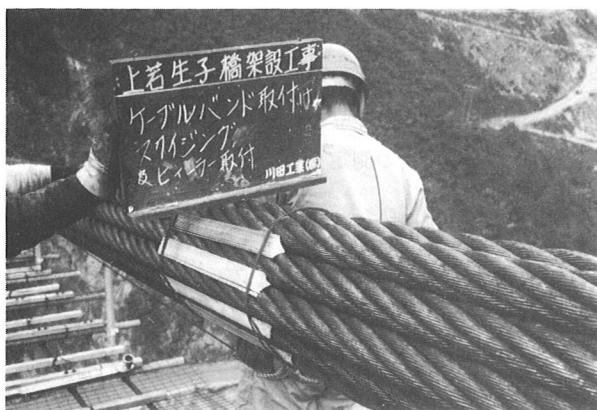
写真-17 イチョウ型フィラーの取付
