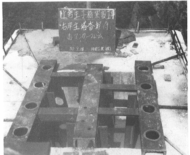
写真-2 主塔沓アンカーフレーム
