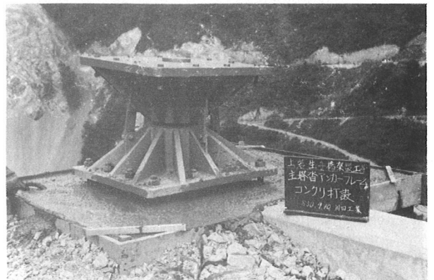
写真-3 主塔沓コンクリート打設
