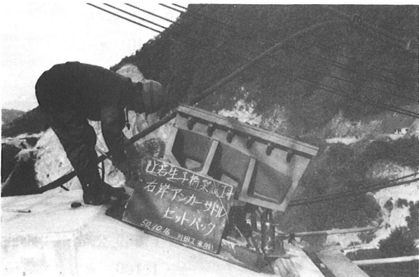
写真-12 アンカーサドルのセットバック
