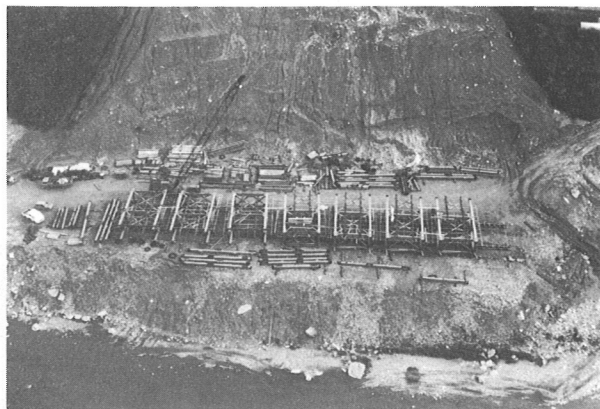
写真-19 補剛桁地組み状況
