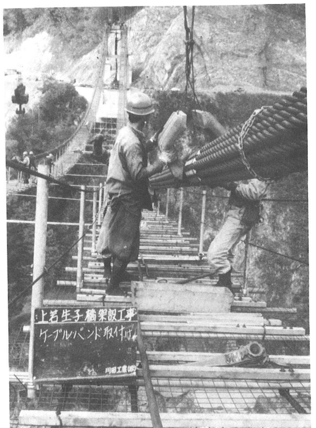
写真-16 ケーブルバンドの運搬、取付
