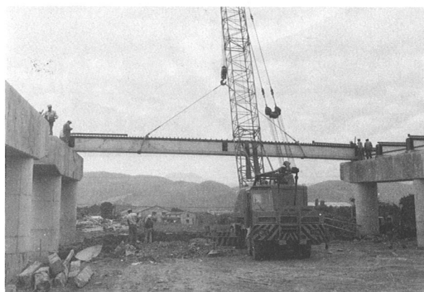
写真-6 Span=19.95m架設
