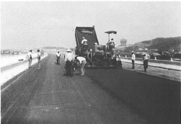
写真-9 舗装作業
