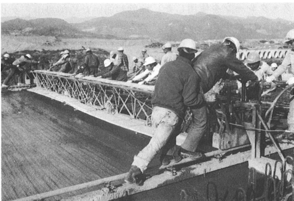
写真-8 フィニッシャー作業
