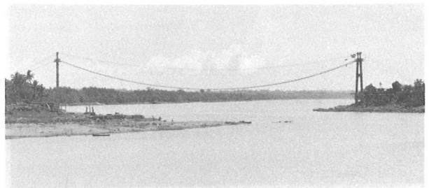
マガピット吊橋全景
