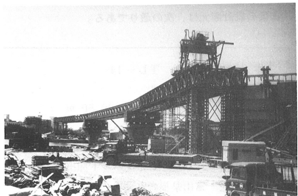
写真 新山下橋架設トラス全景
