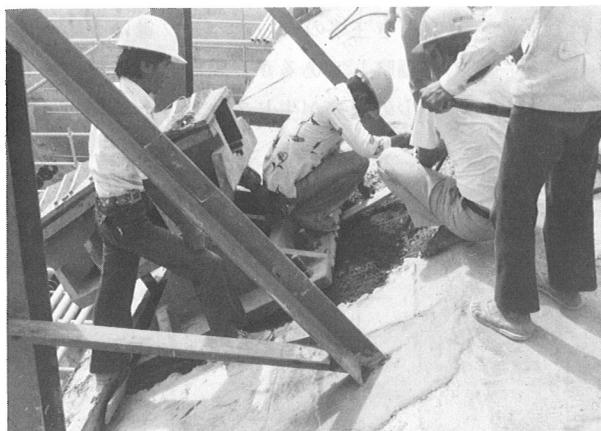
写真-9 スプレーサドルの据付け
