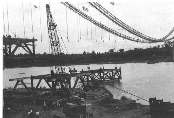
写真-17 補剛桁の地組運搬
