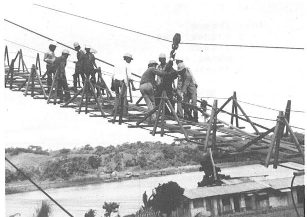
写真-10 ストランドの引出し（側径間）
