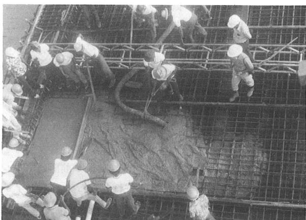
写真-23 コンクリートの打設
