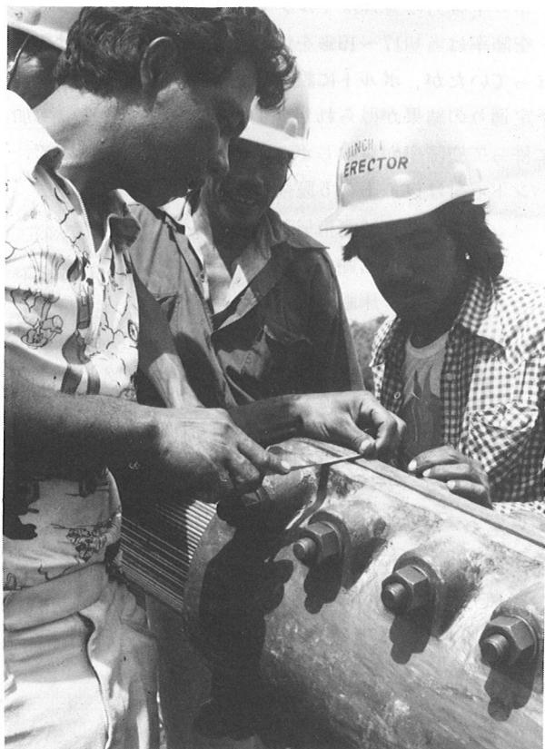
写真-14 バンドの空隙量測定
