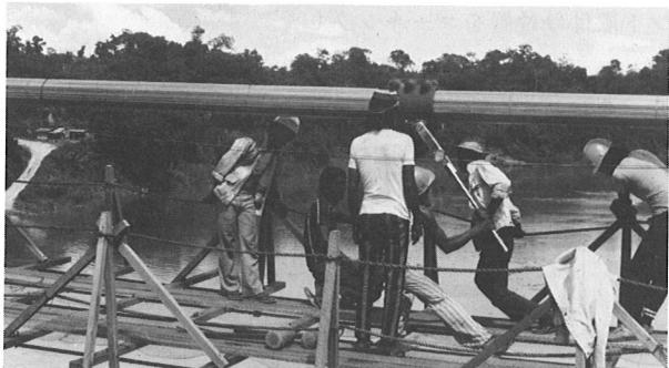
写真-13 ケーブルバンドの締付け
