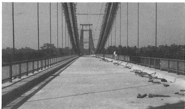
写真-24 床版コンクリート完了
