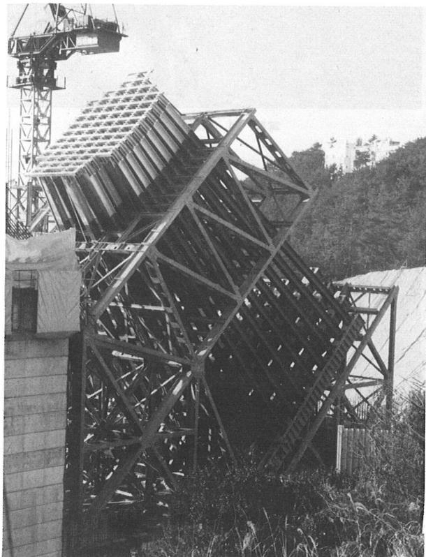
写真-1 アンカーフレーム全景
