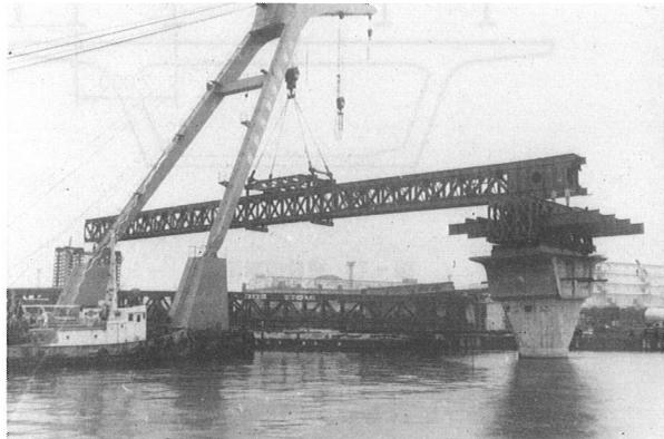
写真-5 架設トラスのブロック架設
