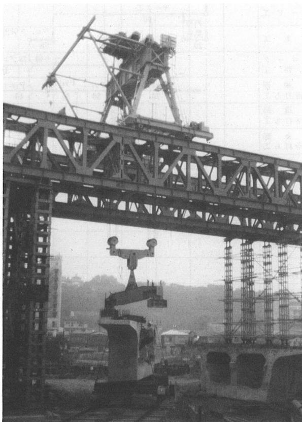
写真-2 ブロック吊込み
