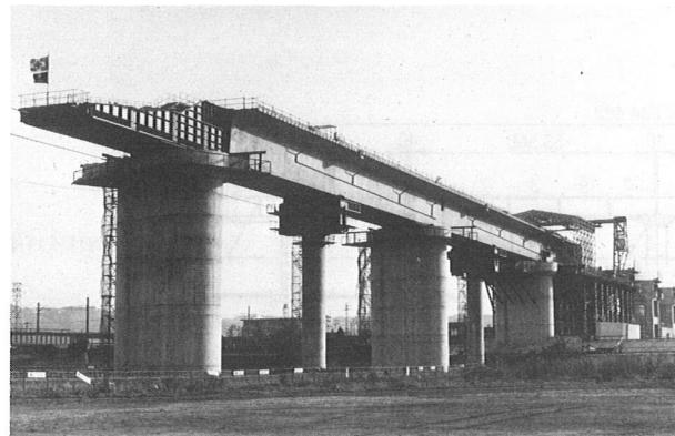
写真-3 押出し時全景
