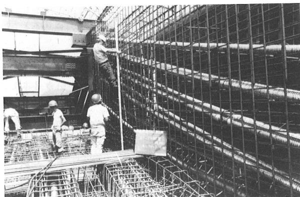
写真-8 端ブロック配筋状態
