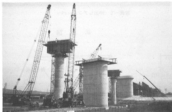
写真-6 仮支柱施工中
