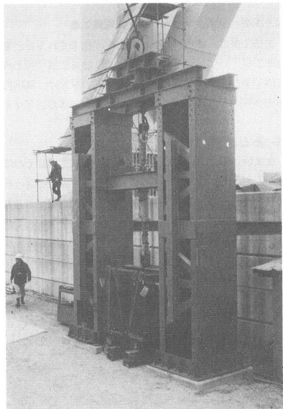
写真-7 制振装置
