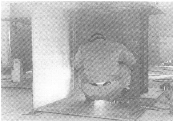
写真-11 溶接状況
