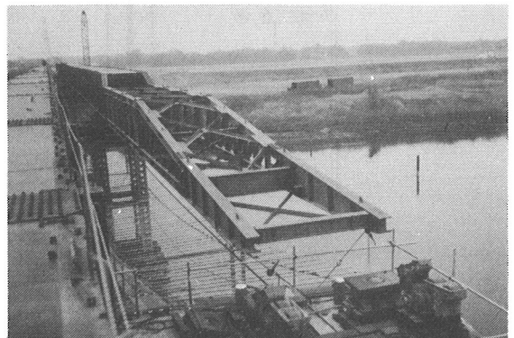
写真-2 引出し架設全景
