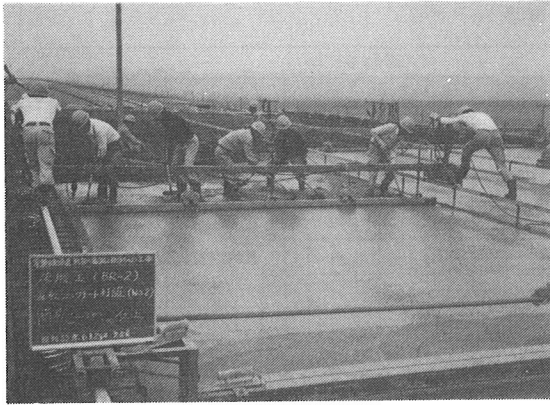
写真-5: 床版コンクリート打設
