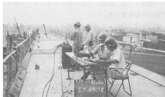
写真-4 主桁横取り作業（運動油圧ポンプの制御状況）
