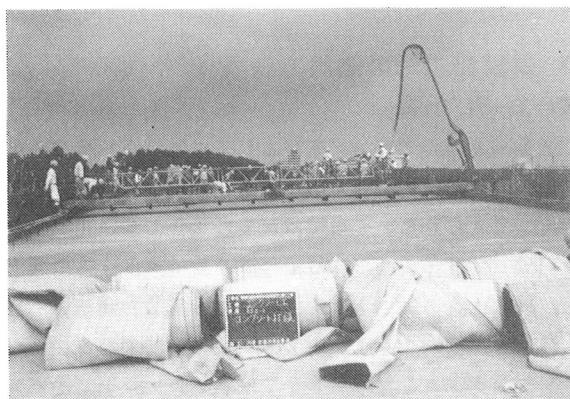
写真-4 コンクリートフィニッシャー、作業台車による天端均し状況
